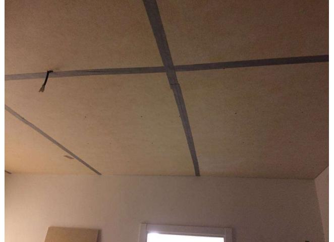
Befestigung von Standard-Gipskartonplatten, die an der Metallstruktur verankert sind (1 Schraube alle 25 cm) und Verfugung
