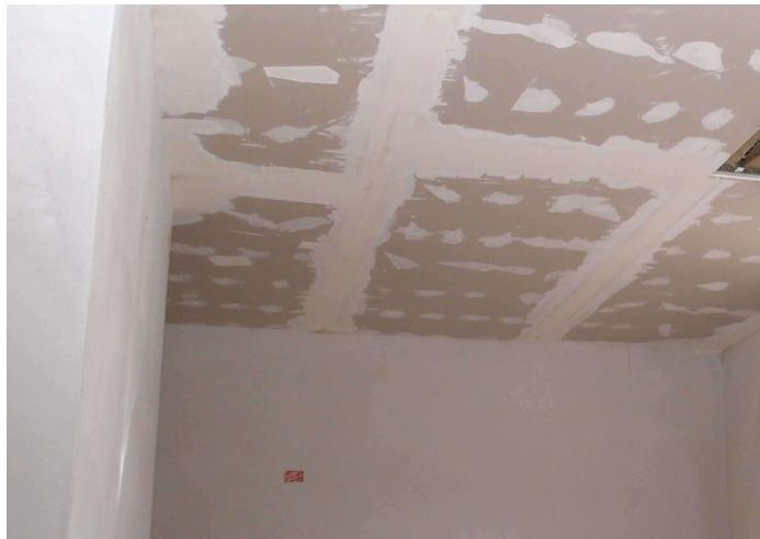
Abdichtung des 4 mm breiten Spals zwischen Gipskartonverkleidung und Wand mit weißem elastischem Silikon
