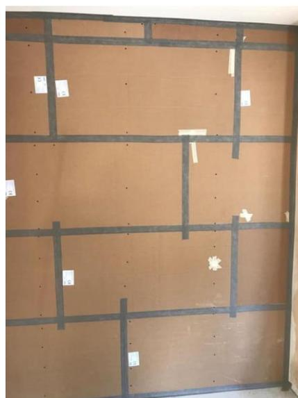
Befestigung von Standard-Gipskartonbekleidungsplatten
