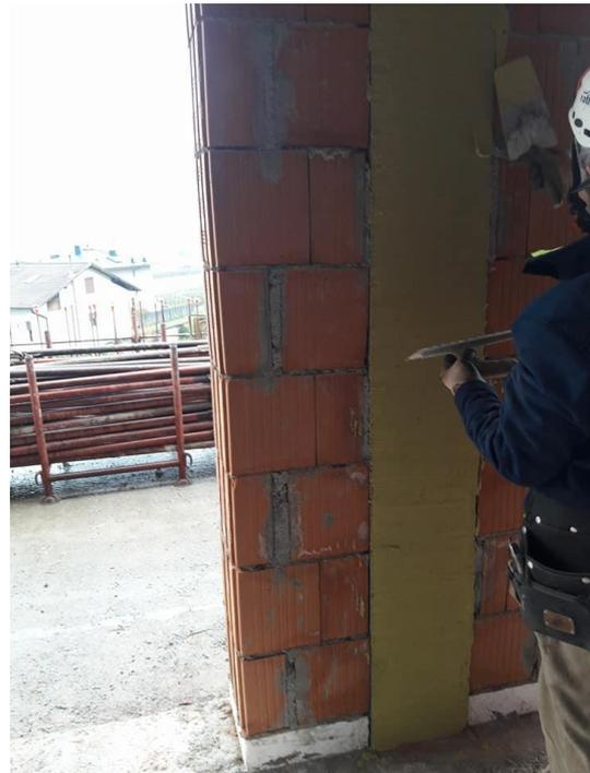
Abb.1: Detail von Silenz WOOD, das an die Wand geklebt und an den Fugen mit Sonora TAPE abgeklebt wurde, und Silenz TAGLIAMURO LATER, das die Wand schneidet
