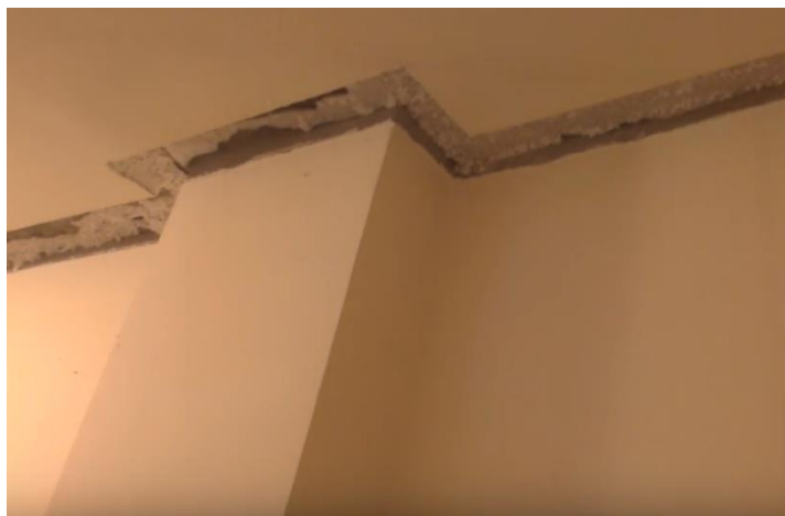
Gefräst, um eine Diskontinuität zwischen den Räumen zu schaffen
