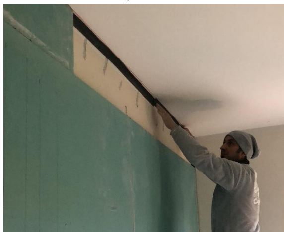
Einbau der Silenz Abdichtung GIPS
