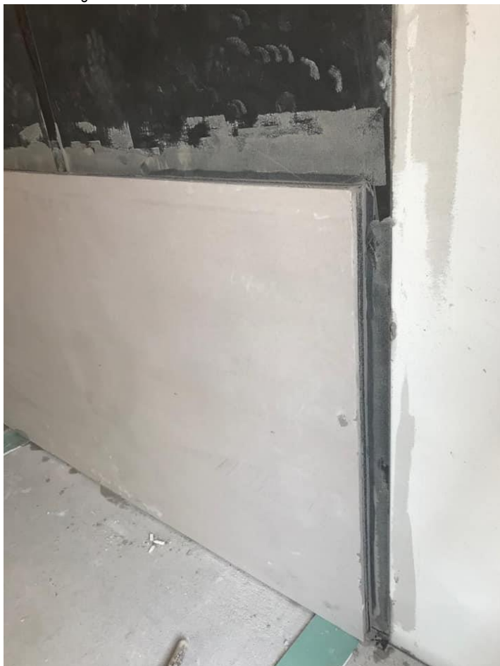
Verklebung der Silenz PUR-MIX-Platte auf der bestehenden Wand
