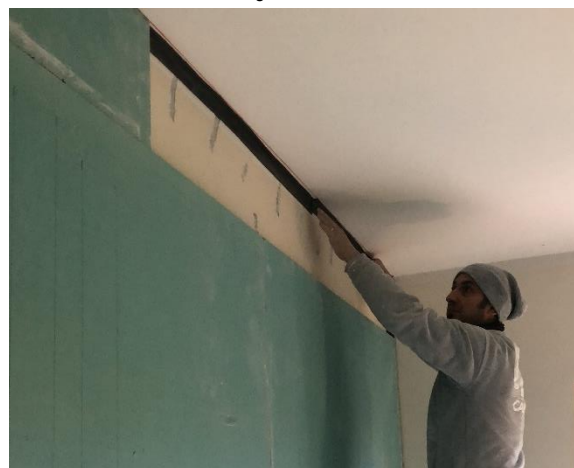
Einbau der Silenz Abdichtung GIPS
